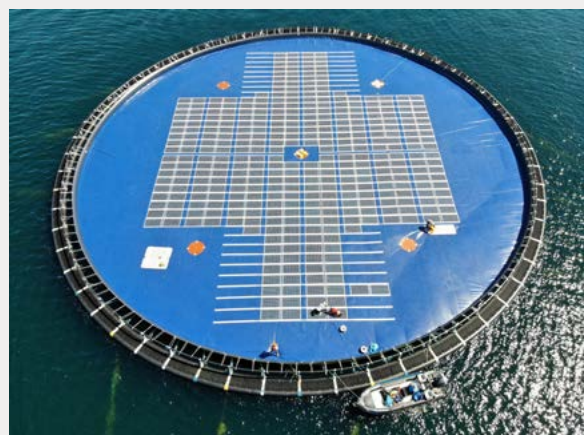
Figur 7. Flytende solanlegg, Statkraft anlegg i Albania. FoU prosjekt. Konseptet er utviklet av det norske selskapet Ocean Sun. Denne løsningen krever lite materiale per kilowatt. Hver enhet består i prinsippet bare av en duk, flyteringer i plast og utstyr til forankring, samt solcellepaneler. Foto: Statkraft.
