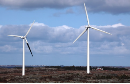
Forskningsprosjektet på Smøla vindpark som brukte kontrastmaling og UV-belysning for å gjøre mastene mer synlige, ble sluttført i 2016.
