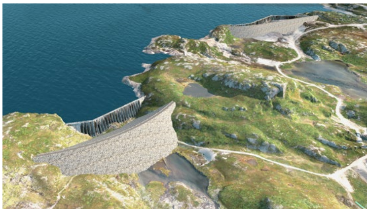
Figuren viser Kjelavatn sin nye hoveddam (venstre) og sperredam (høyre).
