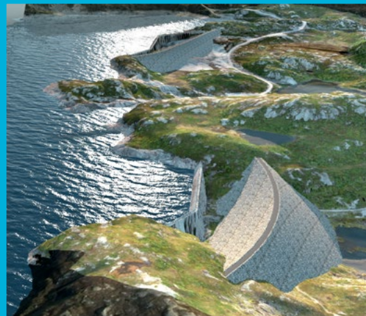
Figuren viser Kjelavatn sin nye hoveddam (venstre) og sperredam (høyre).
